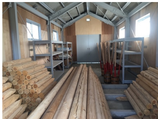
写真5 若森水防倉庫の内部
