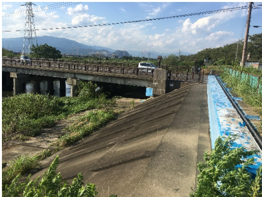
写真2 塩田橋左岸の切割
