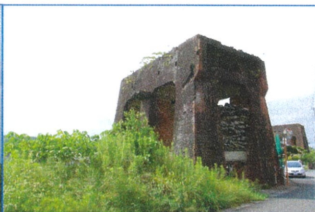
写真 2 飯塚炭鉱の巻き上げ機台座
