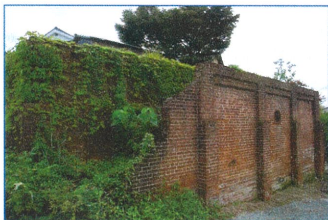
写真 3 忠隈炭鉱の巻き上げ機台座
