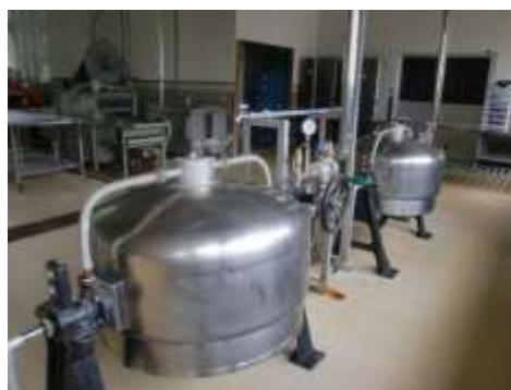
園芸加工場：ジャム製造設備
